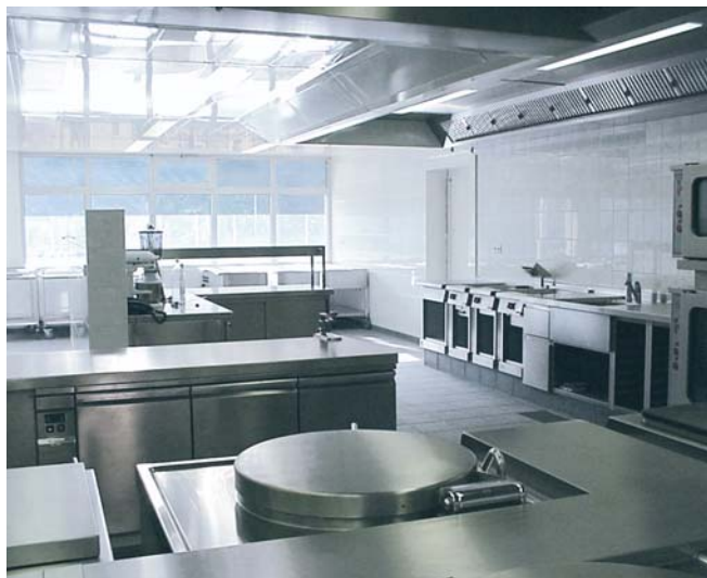
Teil der neuen Küche
